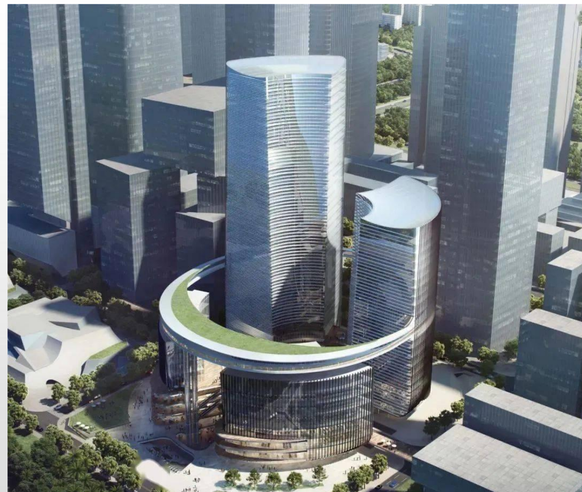
中国电子深圳湾总部基地（前海世界500强总部基地）
